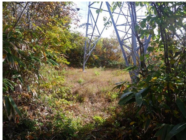
写真⑧ 平坦地に建つ高圧鉄塔2
